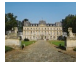
Château de Nointel (Val d'Oise) 44 комнаты
